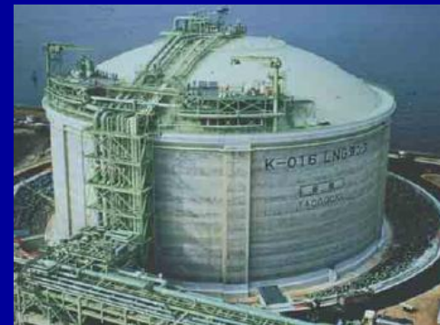
Szabadtéri feszített betontartály Osaka Gas, Japán
